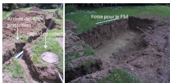
Photo 6 : Photo du dispositif en court de construction.
