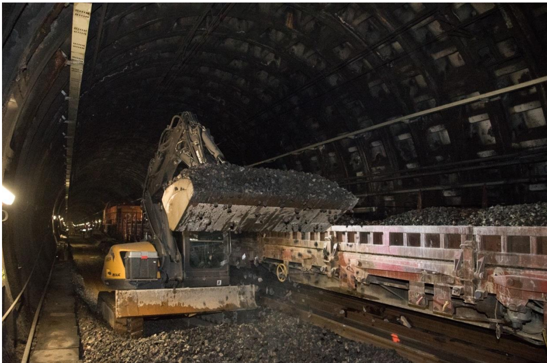
Figure 119. Photo de dégarnissage à la pelle mécanique sur trains de travaux
