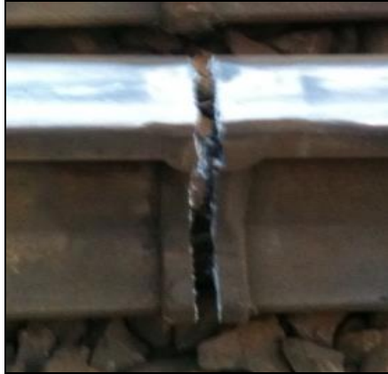
Figure 36. Rupture de rail sur soudure en période froide
