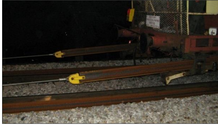
Figure 112. Photo de déchargement LRS
