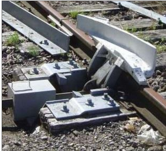
Figure 114. Photo d'un taquet dérailleur
