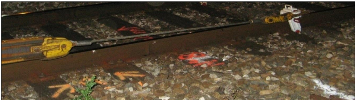
Figure 111. Photo d'un ancrage du LRS au châssis de la voie
