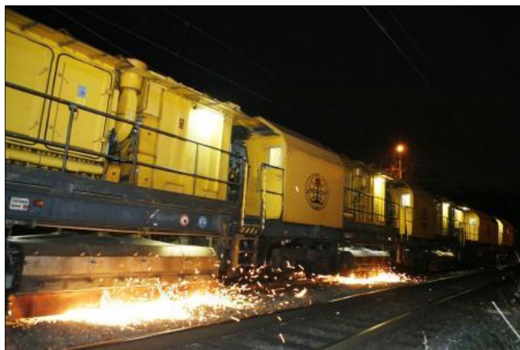
Figure 65. Photo d'un train de meulage SPENO
