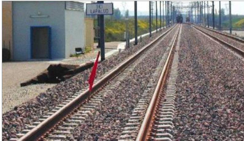
Figure 1. La voie ferrée et ses constituants
