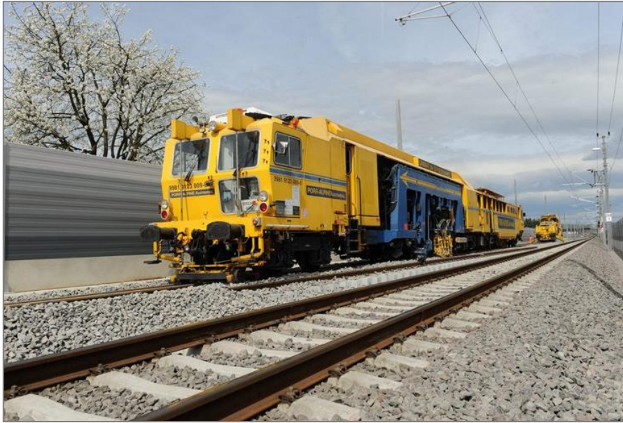
Figure 67. Photo d'une bouresseuse mécanique lourde
