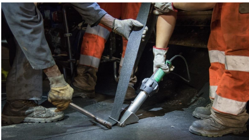
Figure 122. Photo du thermocollage des bandes de jonction
