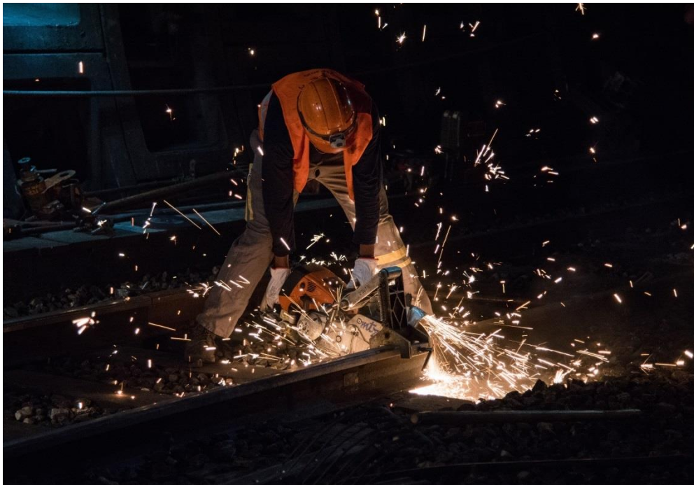
Figure 116. Photo de tronçonnage de rail
