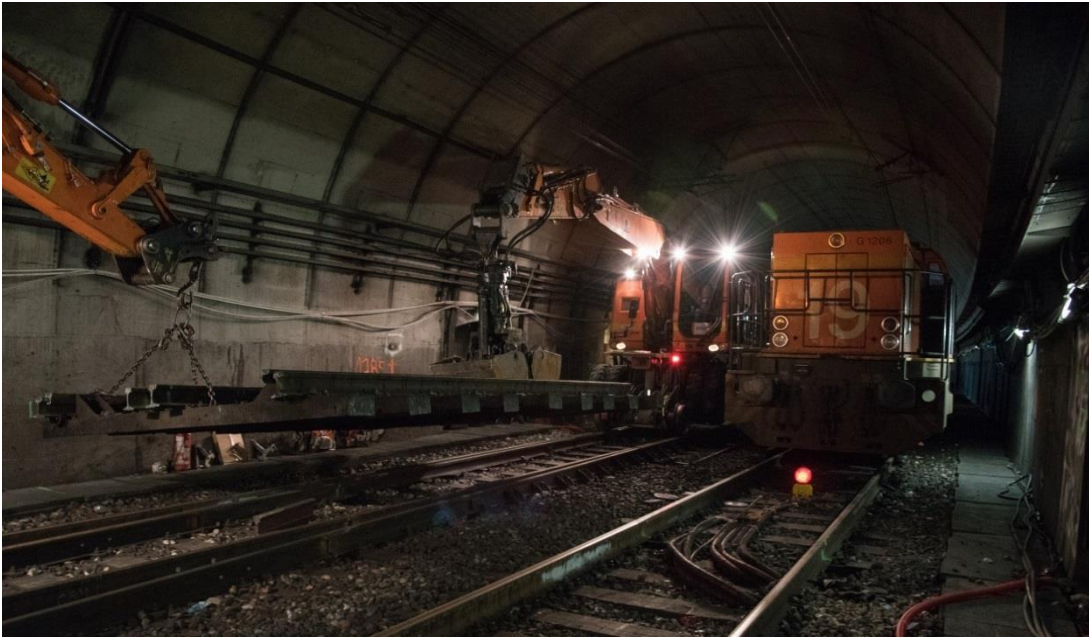
Figure 117. Photo de dépose de panneaux de voie
