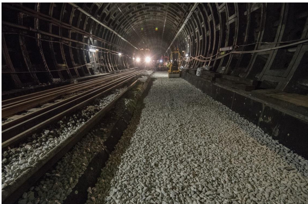
Figure 124. Photo de sous-couche de ballast
