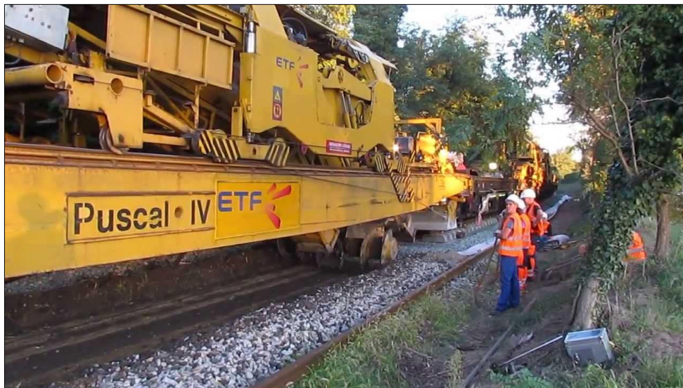
Figure 72. Photo d'excavation à l'aide d'une vis sans fin
