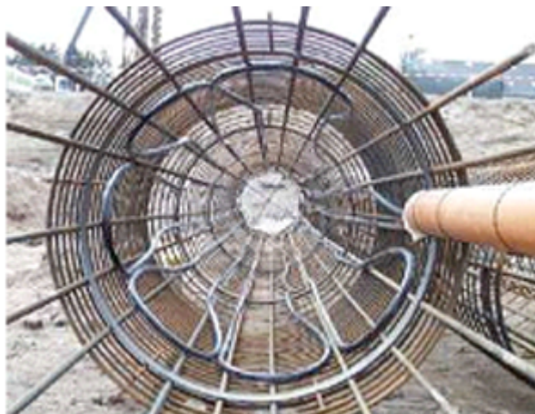
Figure 5. Armature et tubes échangeurs pour la construction d'un pieu géothermique.
